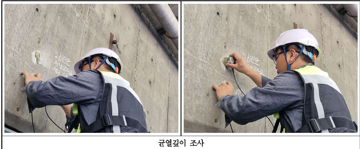
【사진 3.39】 균열깊이 조사 현장사진
