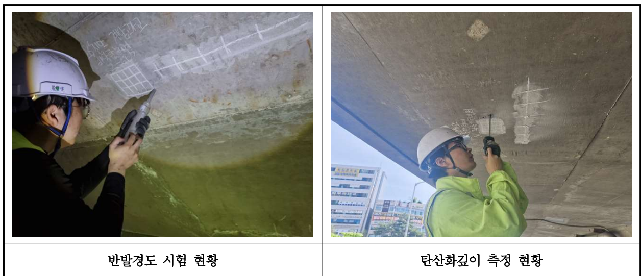
【사진 3.34】 콘크리트 내구성조사 현황
