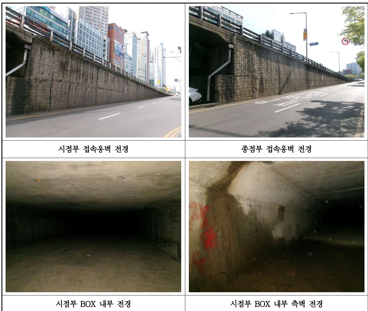
【사진 3.30】 접속옹벽 전경
