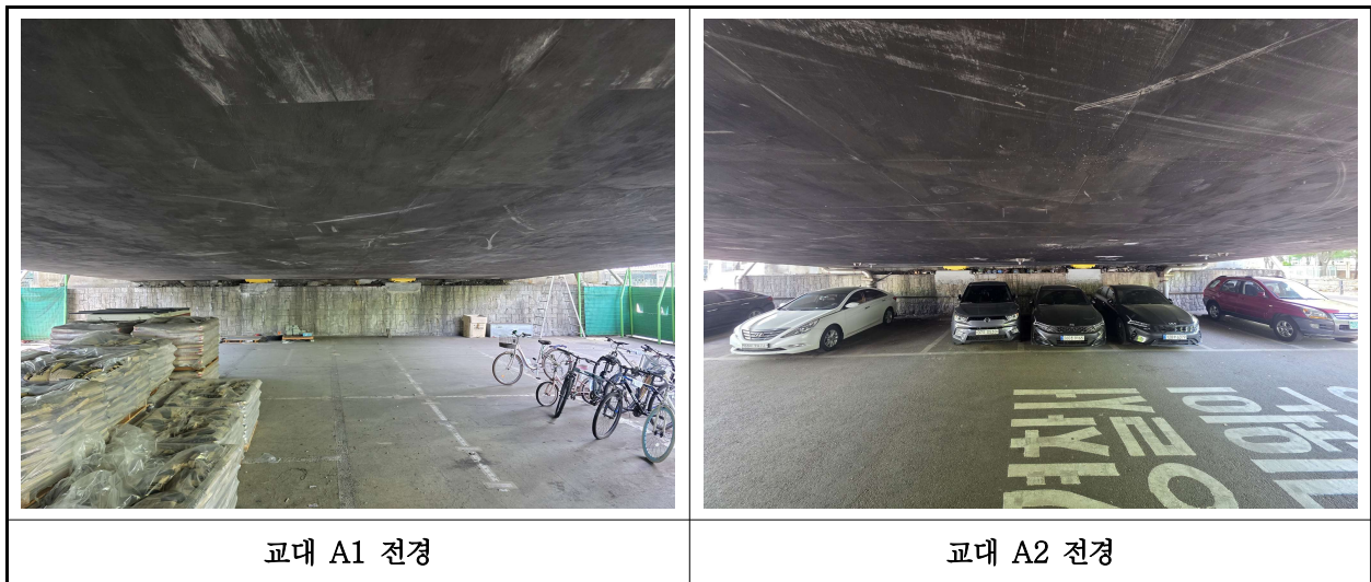
【사진 3.10】 교대 전경
