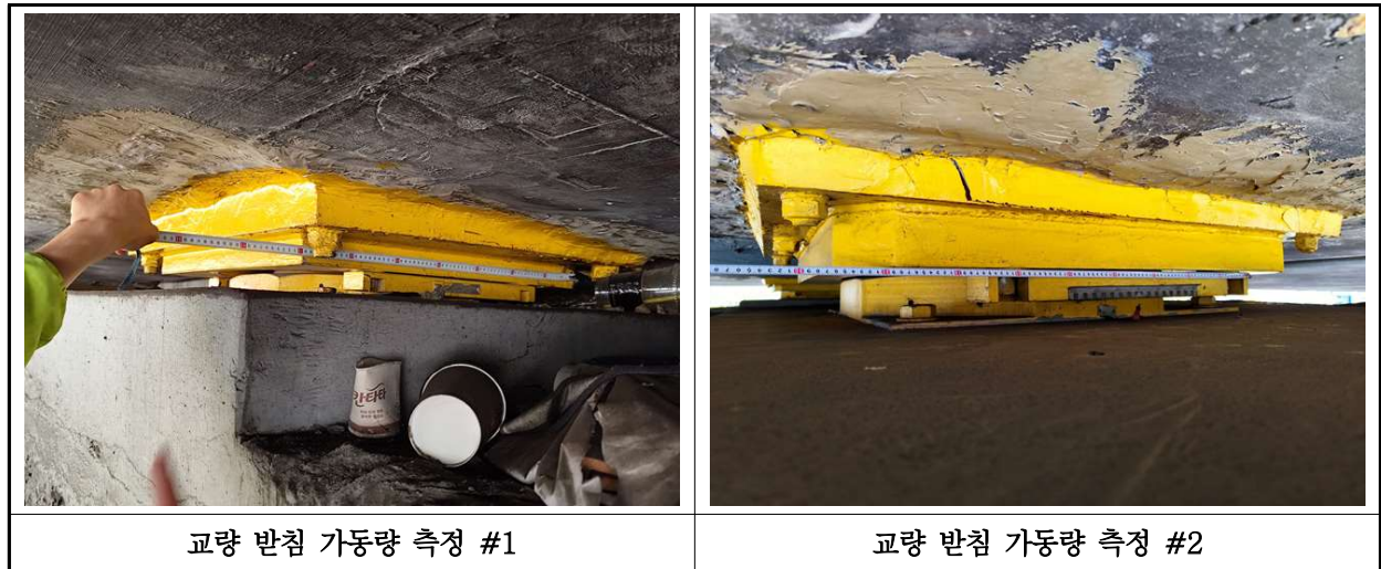
【사진 3.18】 교량받침 이동량 측정
