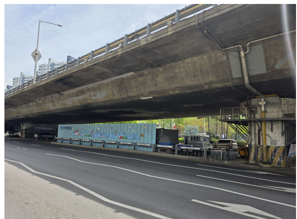
하부 도로점용 현황(S4)
