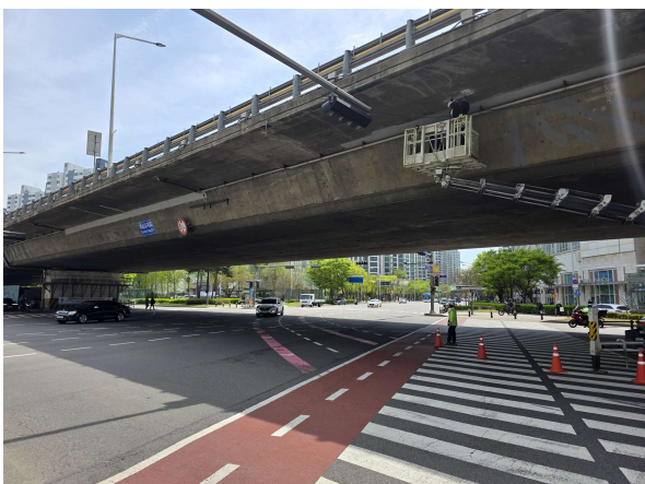
하부 도로점용 현황(S3)
