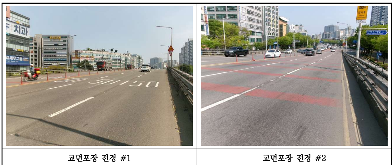
【사진 3.22】 교면포장 전경
