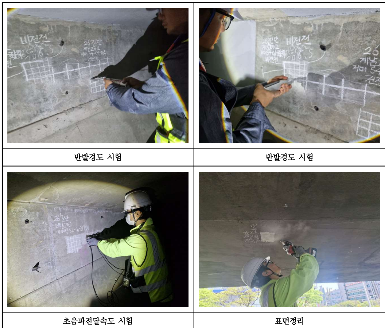
【사진 3.35】 콘크리트강도 시험 현장사진
