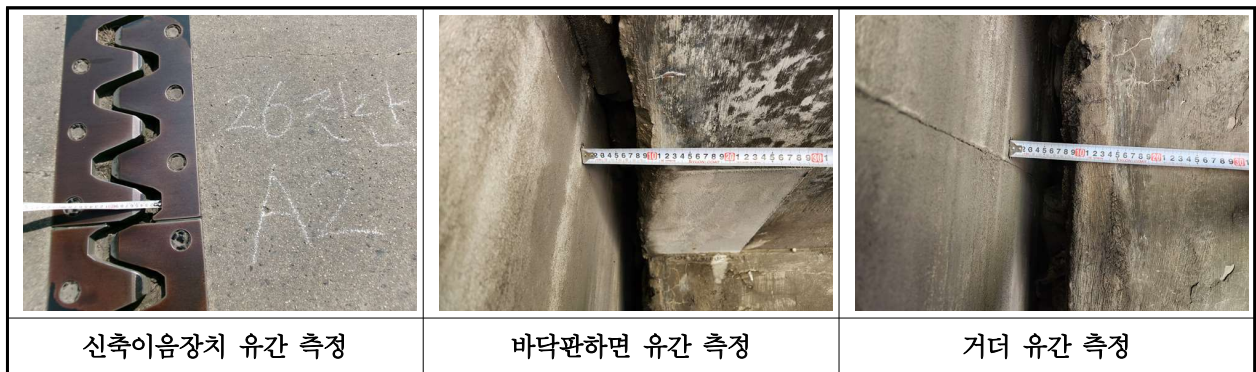
【사진 3.21】 신축이음장치 유간 측정
