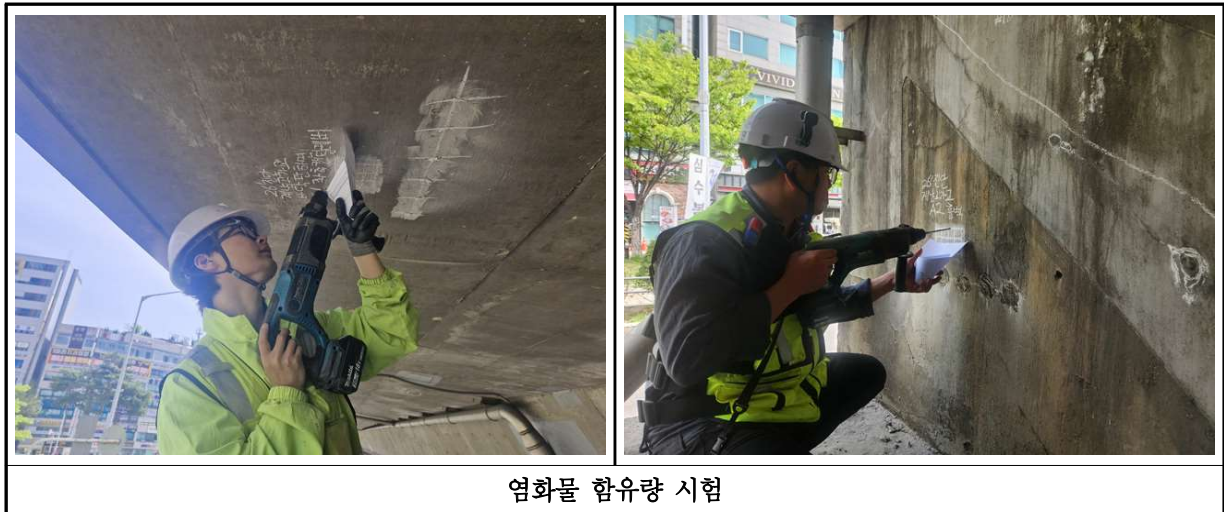
【사진 3.38】 염화물 함유량 시험 현장사진
