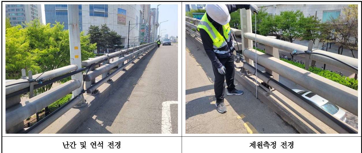
【사진 3.26】 난간 및 연석 전경
