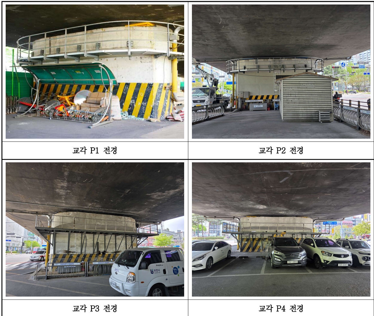
【사진 3.12】 교각 전경
