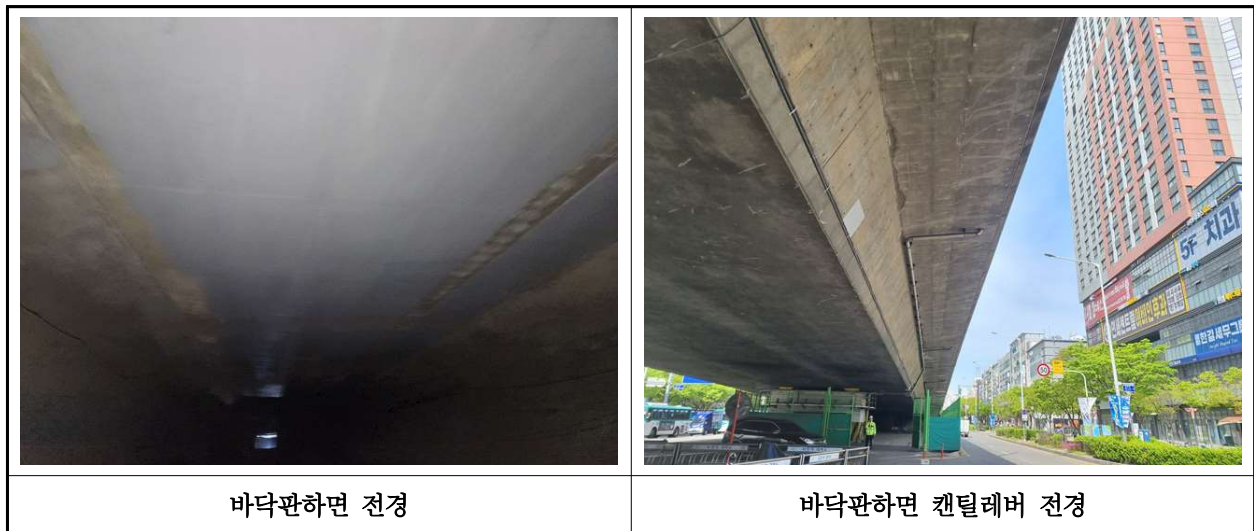
【사진 3.4】 바닥판하면 전경
