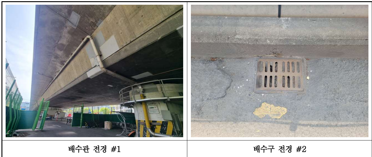
【사진 3.24】 배수시설 전경
