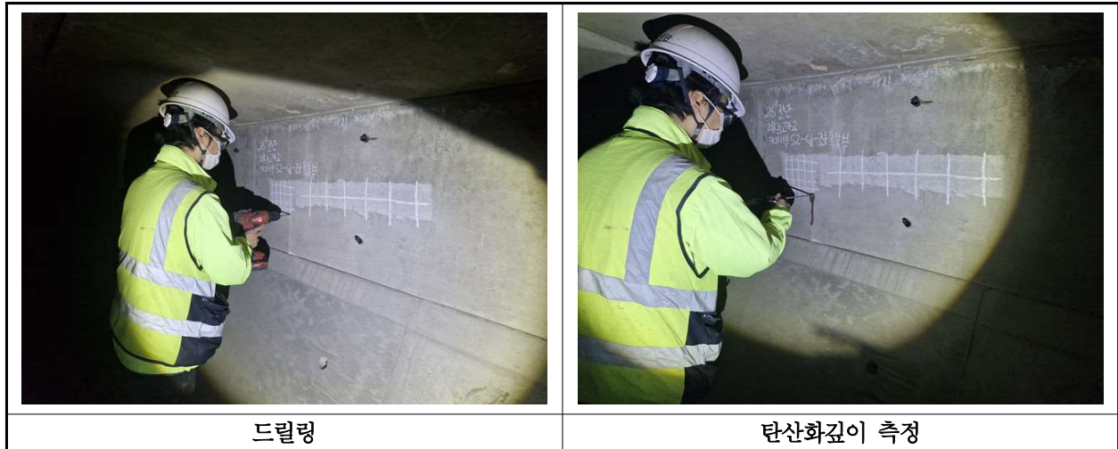
【사진 3.37】 탄산화 깊이 측정 현장사진
