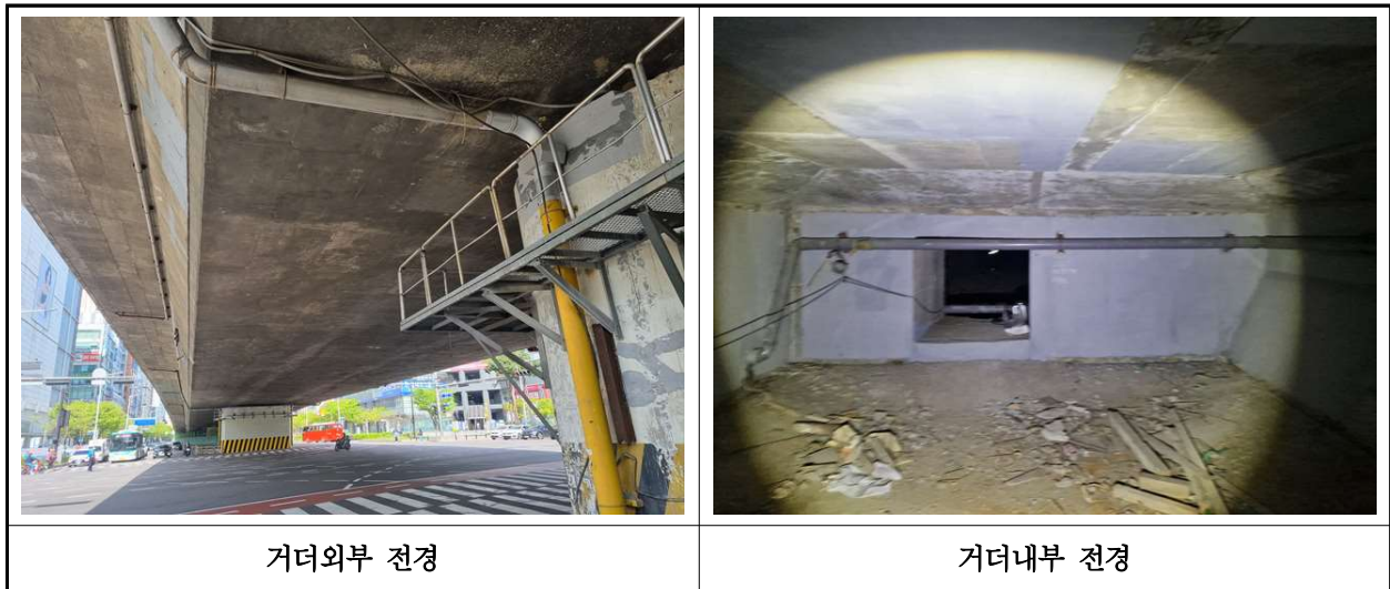
【사진 3.6】 거더 전경
