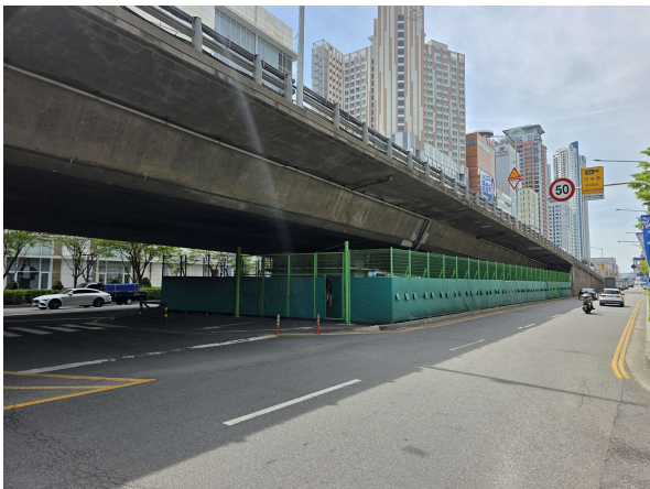
하부 도로점용 현황(S1)
