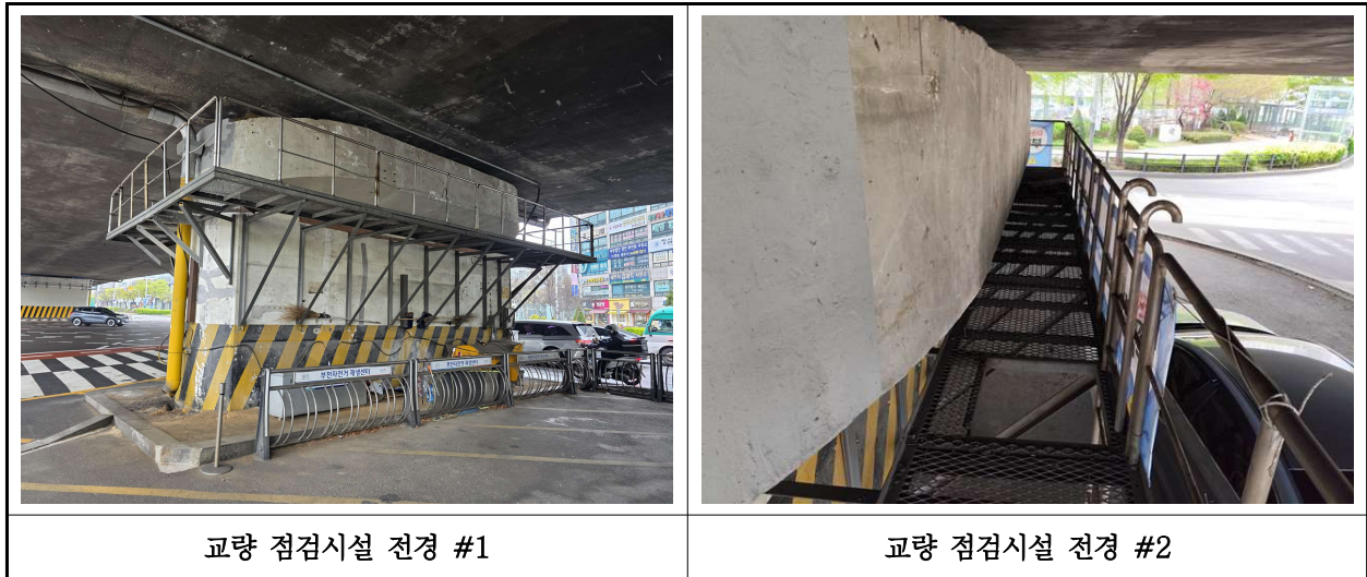
【사진 3.28】 교량 점검시설 전경
