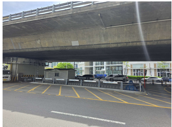
하부 도로점용 현황(S2)
